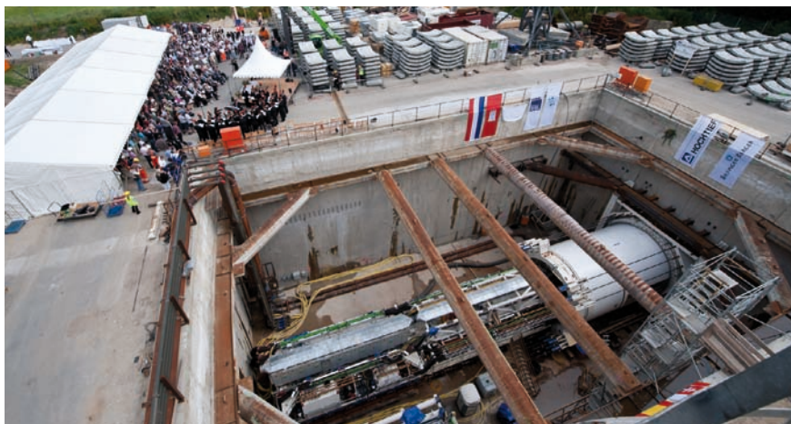
Erste Tunnel- und Bohrertaufe auf der European-XFEL-Baustelle Schenefeld am 30. Juni 2010. Im Vordergrund ist die Tunnelbohrmaschine im Startschacht zu sehen.
